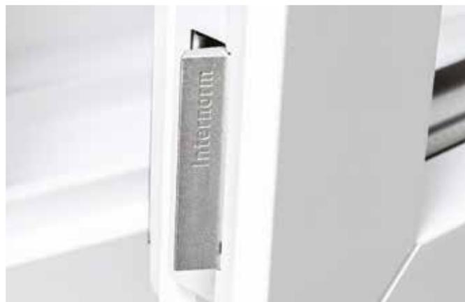
Ces clapets permettent un nettoyage et un entretien aisé de la fenêtre. En effet, la quasi-totalité des pièces de quincaillerie sont invisibles.
